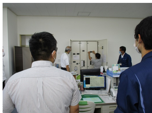
5-4 水害対策訓練（分電盤内の操作）
