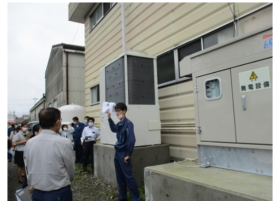
5-2 水害対策訓練（LPガス発電機の操作）
