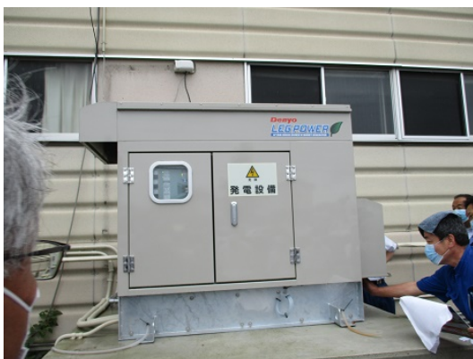
5-3 水害対策訓練（発電機の表示確認）
