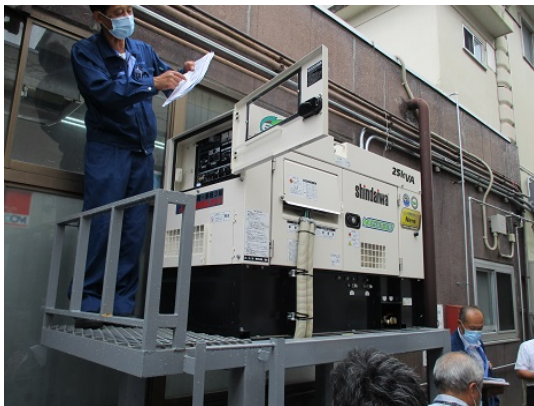
5-1 水害対策訓練（非常用発電機の操作）
