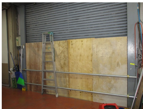
5-6 水害対策訓練（シャッター補強）
