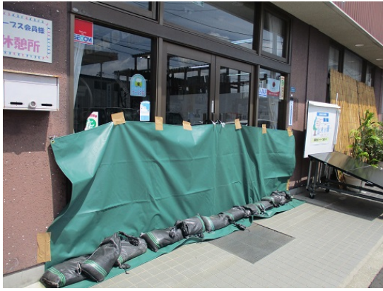
5-3 水害対策訓練（ビニールシート張り）
