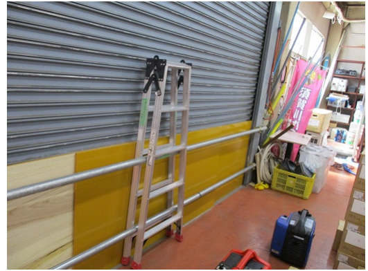
5-6 水害対策訓練（シャッター補強）
