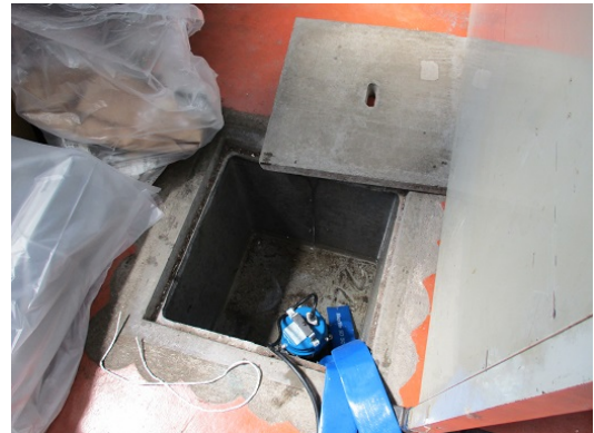
5-2 水害対策訓練（水中ポンプ準備）
