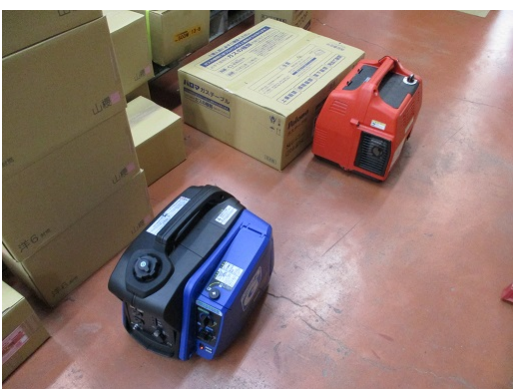
5-1 水害対策訓練（水中ポンプ準備）
