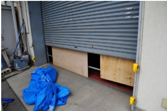
5-5 水害対策訓練（シャッター補強）
