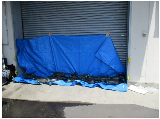
5-4 水害対策訓練（ブルーシート張り）
